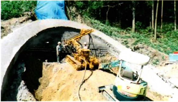
⑫ ロックボルト削孔、モルタル注入、鉄筋挿入
