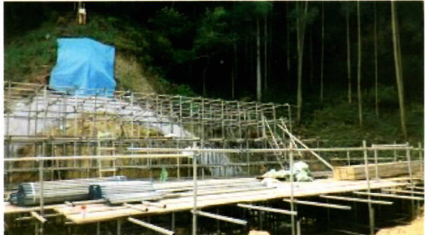
④-1 斜め補強材 削孔、モルタル、鉄筋挿入
