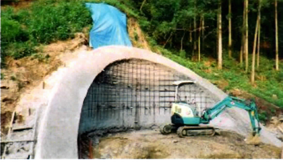
⑫ ロックボルト削孔、モルタル注入、鉄筋挿入
