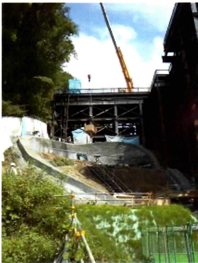
⑭-1 掘削、揚土
