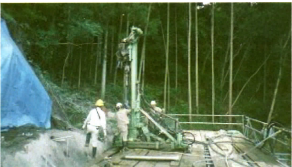
④-2 斜め補強材 削孔
